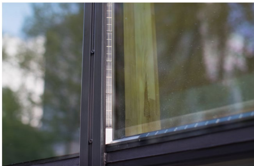
Рисунок 2 – Окна, работающие как солнечные панели
